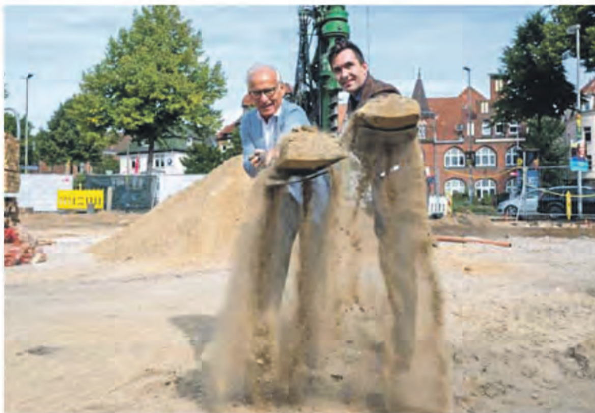
Für den Spatenstich von Andreas Ohlms und Michael Arends (r.) gab es eine kurze Pause, dann ging es weiter auf der Baustelle an der Ecke Lindenstraße/Barckhausenstraße. Foto: t&w
